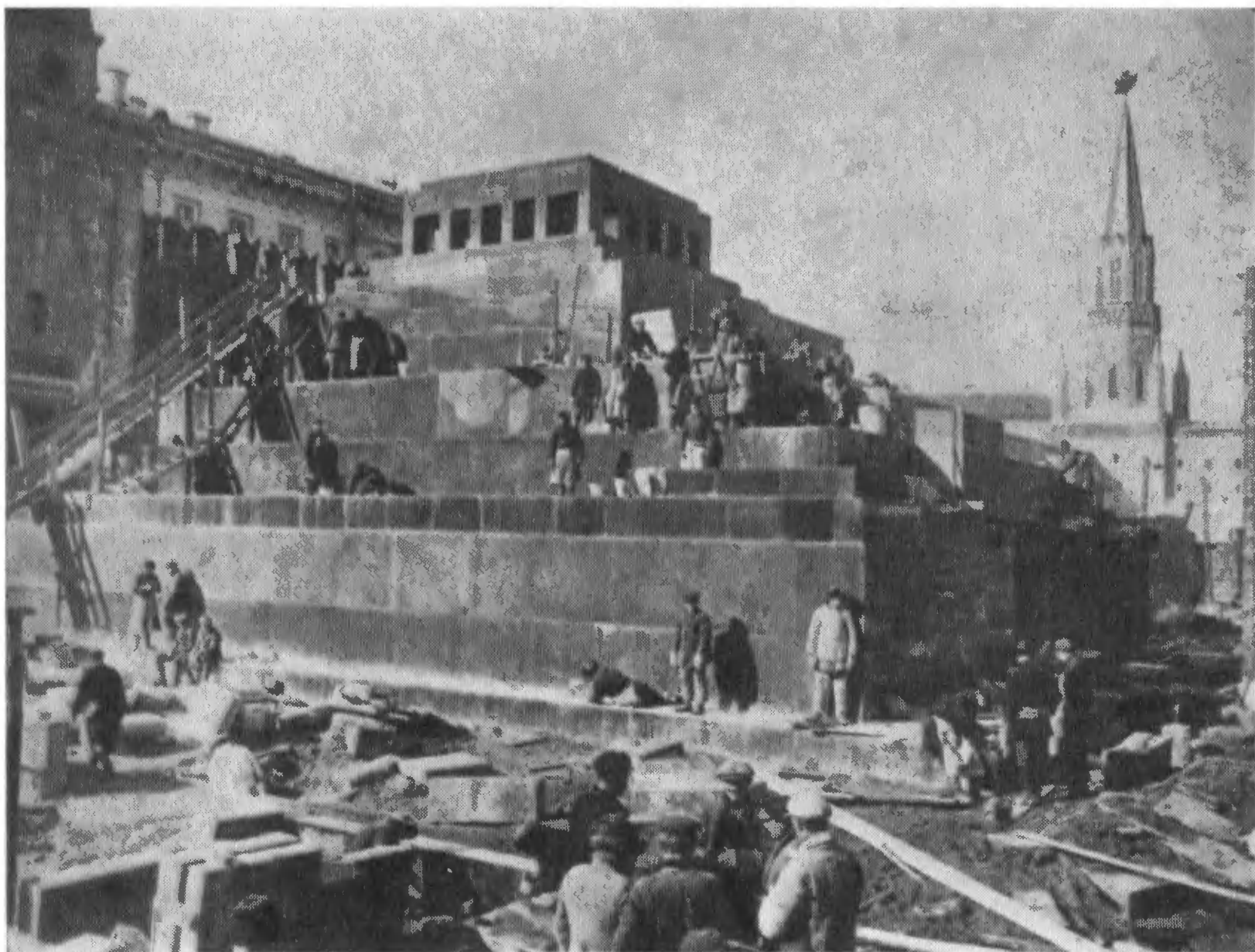
Строительство гранитного Мавзолея Ленина. 1930 г.
